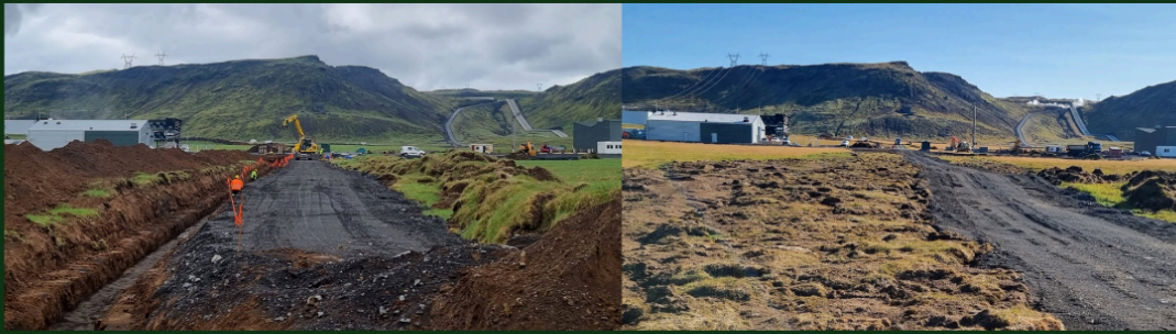
Yfirborðsfrágangur með staðargróðri á skurðstæði vatnslagnar í Jarðhitagarði Orku náttúrunnar sumarið 2023.
